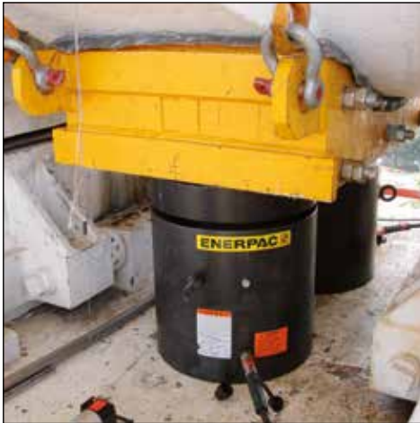
▲ Schwerlasthubanwendung und Fundamentausrichtung. Stellring gewährleistet sicheres mechanisches Halten der Last, auch über einen längeren Zeitraum.
