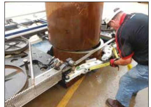
▲ Rohrtrennung mit BS-Bandsäge.
